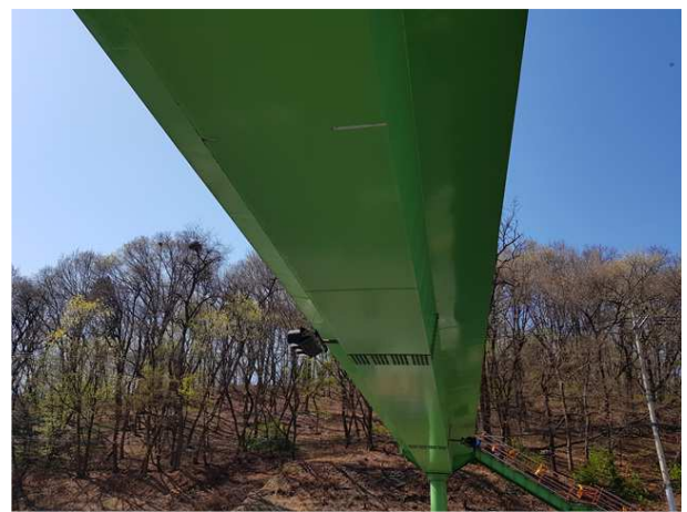
바닥판하면 및 거더 전경
